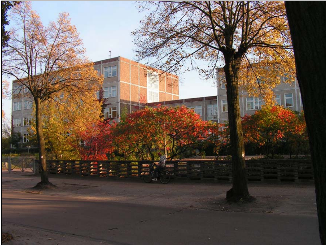
Blick auf die Schule von der Straße aus
