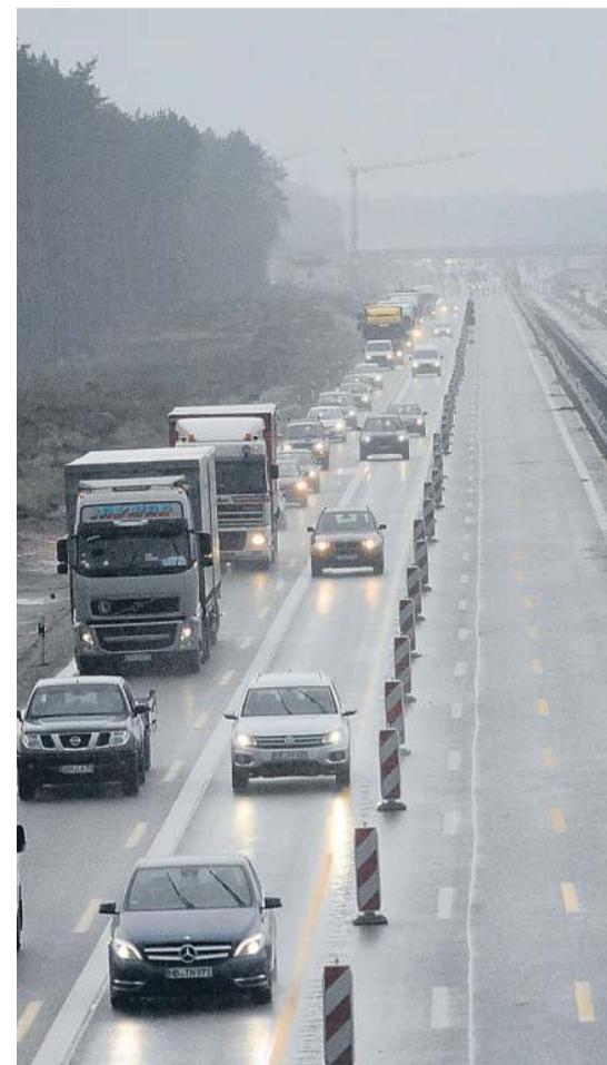
Beengt: Der gesamte Verkehr wird für mehrere Monate auf die südliche Fahrbahn (l.) des Nordrings geleitet.
