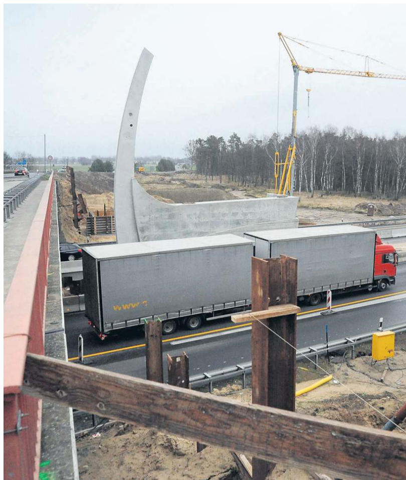
Brückenschlag: An der Anschlussstelle Kremmen wurde bereits mit dem Bau der Autobahnbrücke über die Bundesstraße 273 begonnen. FOTOS: ROBERT ROESKE (2)
